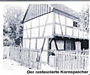
Der restaurierte Kornspeicher
